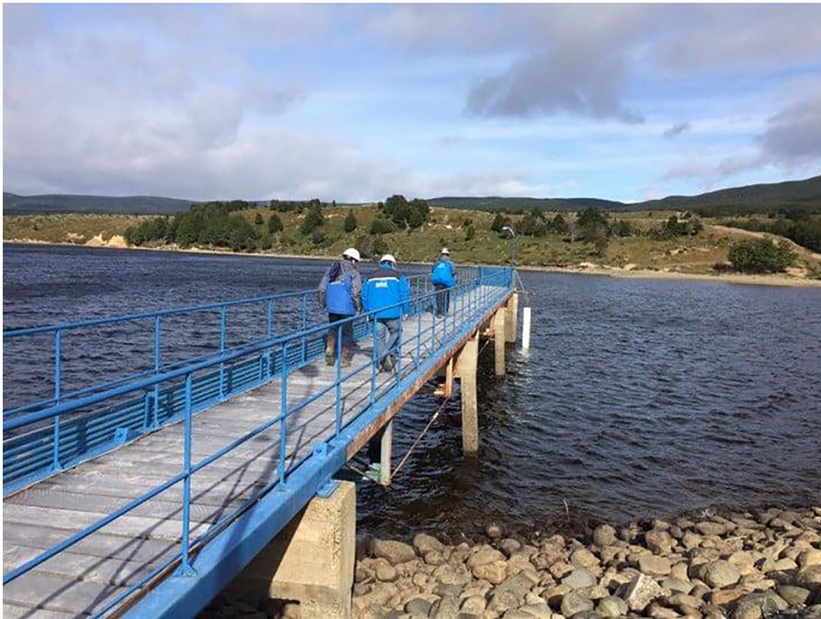
Figura 15. Embalse Laguna Lynch, una de las principales fuentes de agua potable para la ciudad de Punta Arenas
